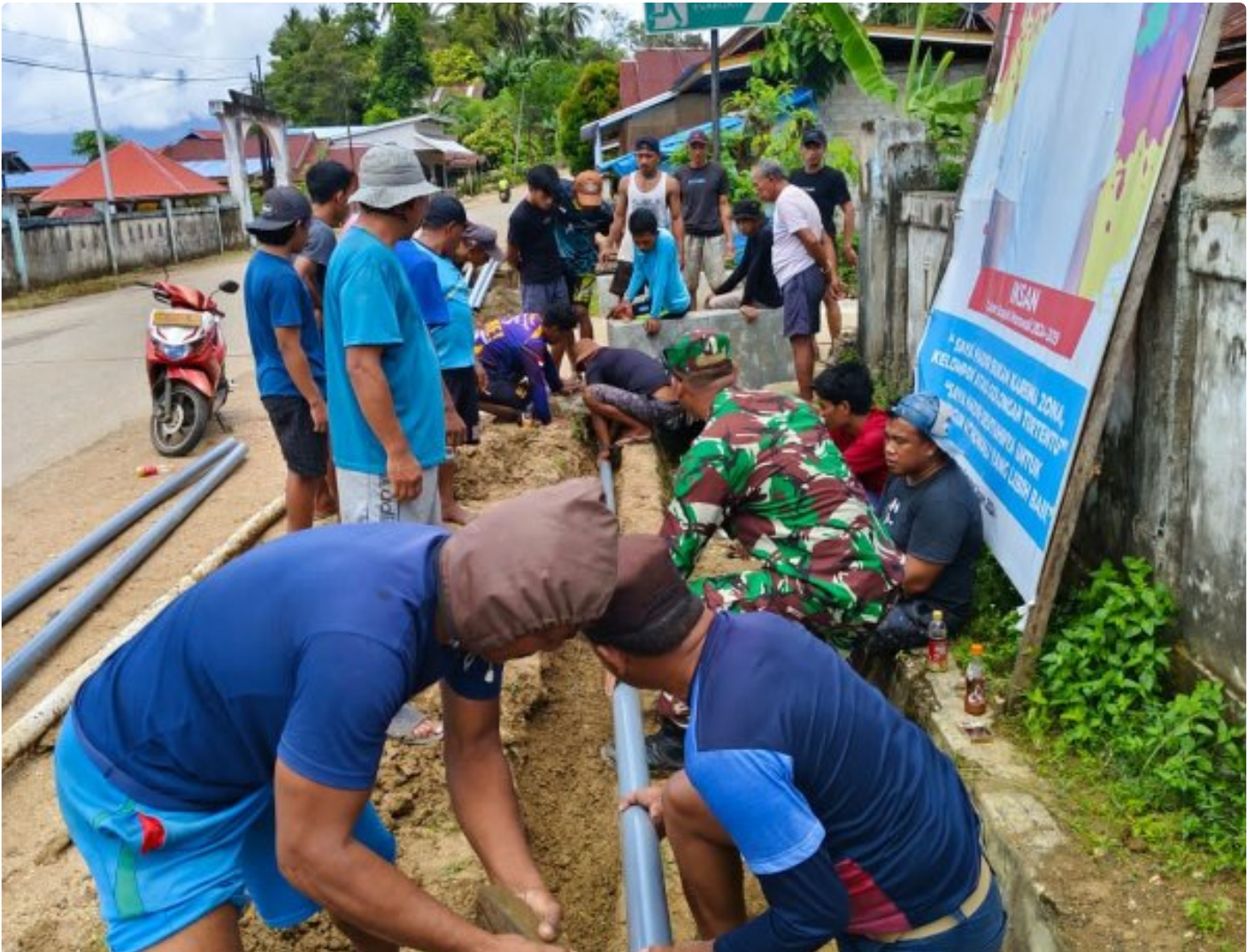
Proses pemasangan pipa air bersih di bantu Babinsa 1311-02/BS
